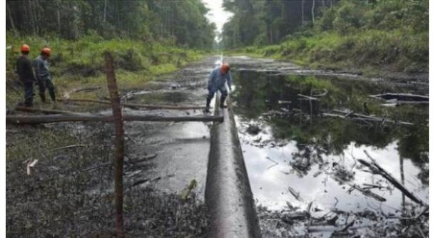
De acuerdo a lo informado por la empresa, la fuga del crudo fue contenida en el canal de flotación del oleoducto. Los cortes fueron de 8 y 6 centímetros.
