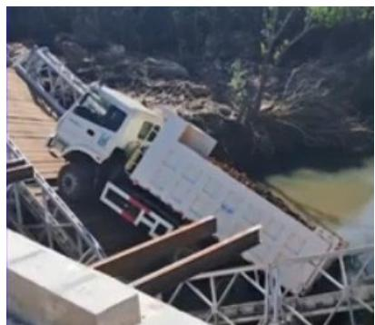
El puente que el Ejército había construido en Paso del Cerro (Tacuarembó) se derrumbó tres meses y medio después de su instalación sobre el arroyo Bañado de Rocha. El ministro de Transporte, señaló que colapsó porque "el vehículo que iba con mayor capacidad de carga de la permitida".
