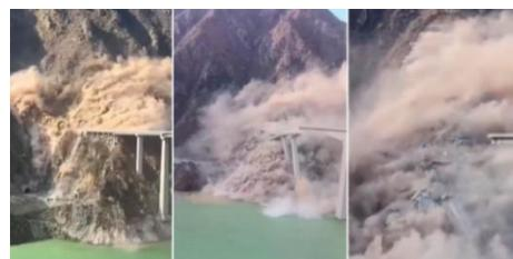
En la provincia de Sichuan, China, se derrumbó un tramo del puente Hongqi, de 758 metros de largo, debido a un deslizamiento de tierra que afectó los apoyos de su estructura. Aunque las autoridades habían cerrado la ruta un día antes tras detectar grietas y deformaciones en las laderas, el colapso igualmente se produjo y generó gran impacto en la movilidad regional. Las pérdidas materiales incluyen la destrucción parcial
